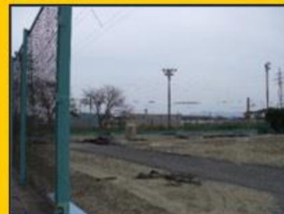
仮設住宅取り壊し後(H21y)
